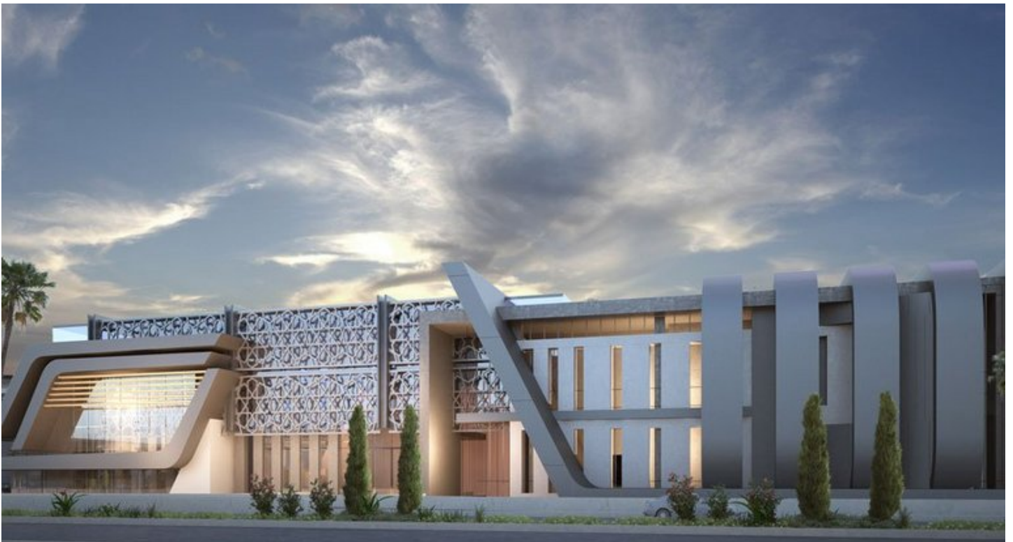
G+D unterstützt Ägypten bei der Sicherung und Modernisierung seiner Bargeldversorgung. Südöstlich von Kairo plant und baut G+D eine integrierte Anlage für die Produktion und die Bearbeitung von Banknoten
